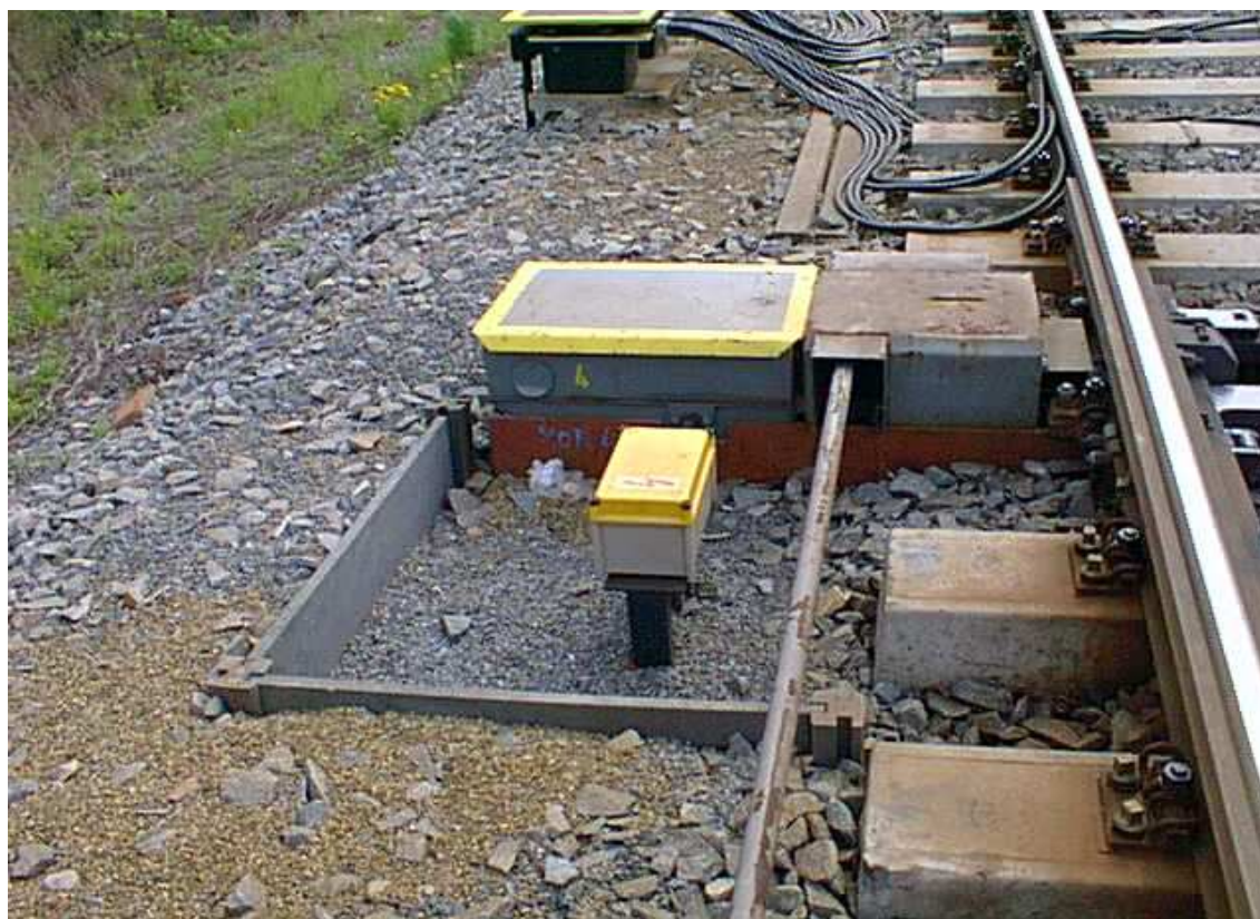
Žlabový pražec s vloženým elektrickým přestavníkem
