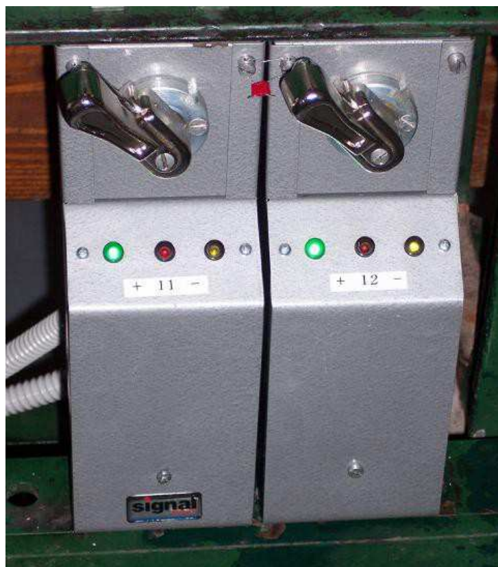
Výhybkový manipulátor - novější provedení
