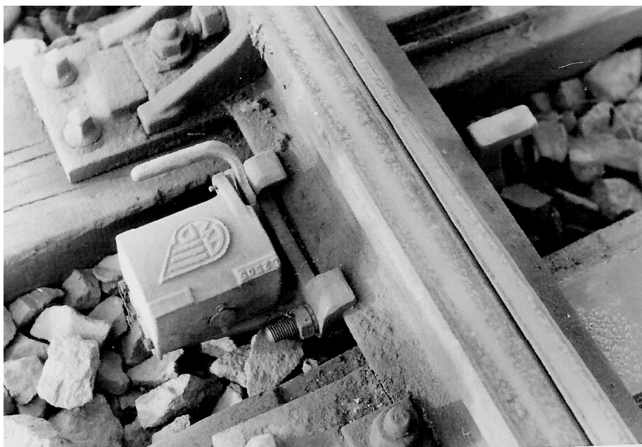
Uzamčený výměnový zámek bez ochranné skříňky
