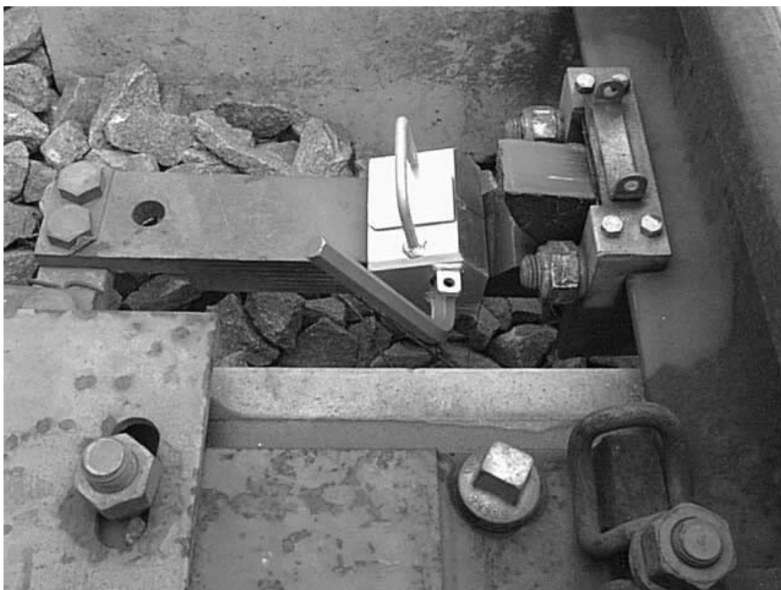
Přenosný zámek čelistového závěru
