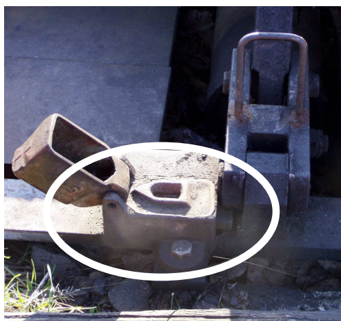
Samovratný přestavník (zapnutý do samovratné činnosti)
