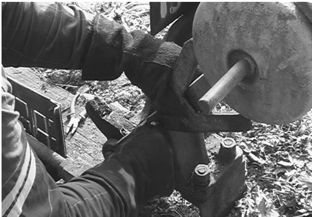
Otočení podpěrné vidlice výměníku
