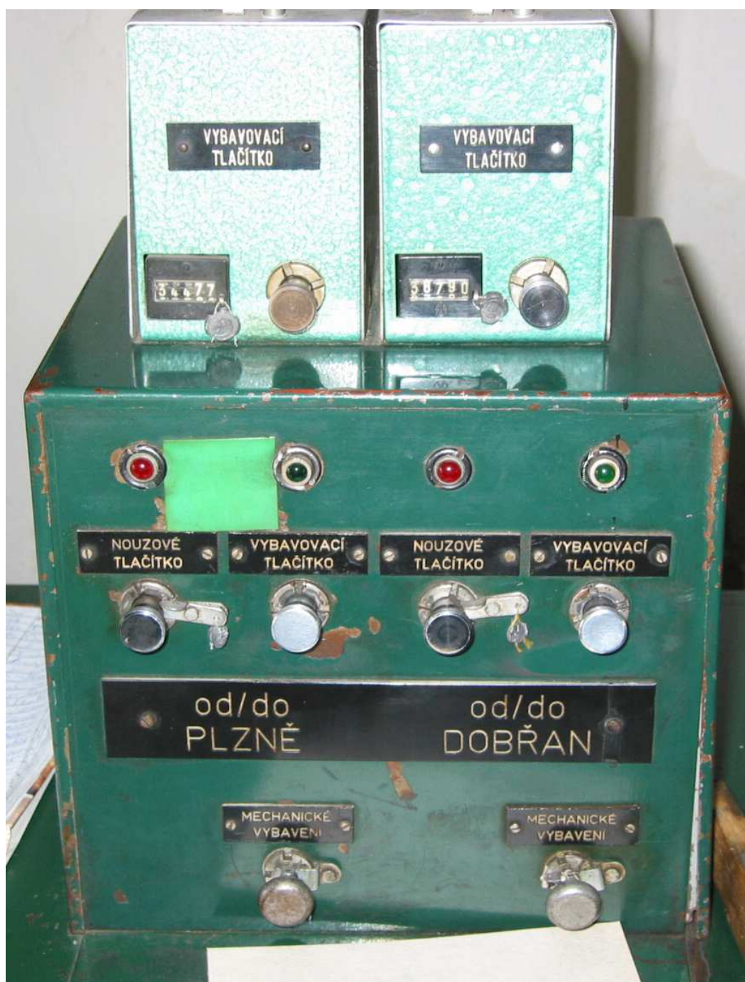
Samočinný závěr výměn – reléový vybavovač
