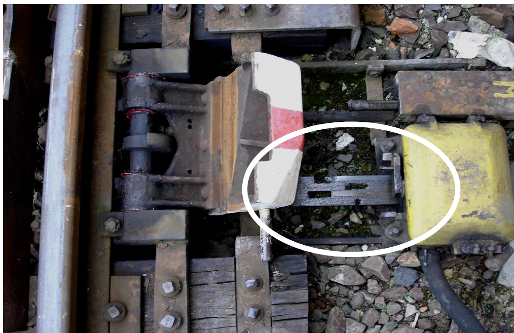
Elektrický výměnový zámek – pohled na kontrolní tyč výkolejky
