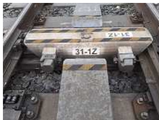
Obrázek 4 – Závěrové zámky u výhybky s hydraulickým přestavníkem, s možností zajištění výhybky v obou koncových polohách
