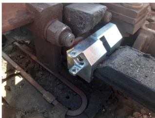
Obrázek 12 – Nasazení PZČZ do vybraní závorovací pravítka
