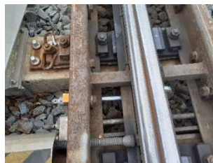
Obrázek 21 – Zajištění PHS pomocí PZ PHS velkého typu
