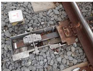
Obrázek 3 – Závěrové zámky u výhybky s elektrickým přestavníkem (pro PHS), s možností zajištění výhybky v obou koncových polohách
