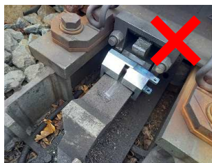
Obrázek 11 – Vybrání závorovacího pravítka i s příkladem osazení PZČZ, které nesplňuje nominální hodnotu a nesmí se použít k zajištění výhybky PZČZ
