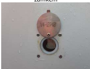
Obrázek 36 - Detail otvoru na skříni pro vložení kliky
