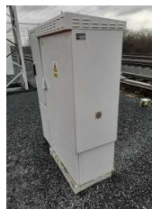
Obrázek 35 – Skříň s otvorem pro kliku u výhybky s hydraulickým přestavníkem
