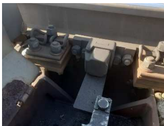
Obrázek 5 – Příklad závěrového zámku u výhybky s elektrickým přestavníkem, trvale osazeného u paty kolejnice
