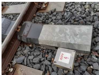
Obrázek 1 – Nasazený kryt, pod kterým je na závorovacím pravítku závěrový zámek
