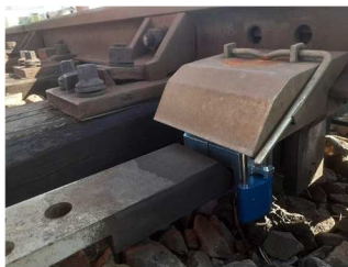
Obrázek 17 – Nasazený kryt svěrací čelisti po zajištění a uzamčení výhybky PZČZ
