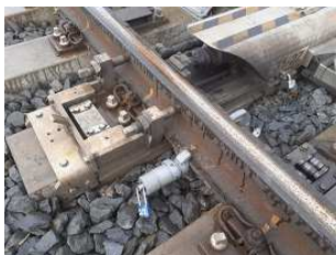
Obrázek 34 - Příklad zajištění výhybky s hydraulickým přestavníkem (výměna) přenosným výměnovým zámekem
