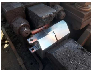
Obrázek 14 – Zapevněný PZČZ po dotažení inbus klíčem
