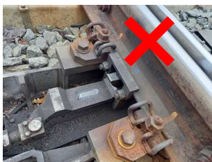
Obrázek 10 – Vybrání závorovacího pravítka, které nesplňuje nominální hodnotu a nesmí se použít k zajištění výhybky PZČZ
