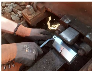
Obrázek 13 – Sevržení svěracích čelistí PZČZ utažením inbus šroubu
