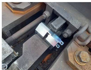
Obrázek 9 - Příklad správného umístění PZČZ ve vybraní závorovacího pravítka (6 cm)
