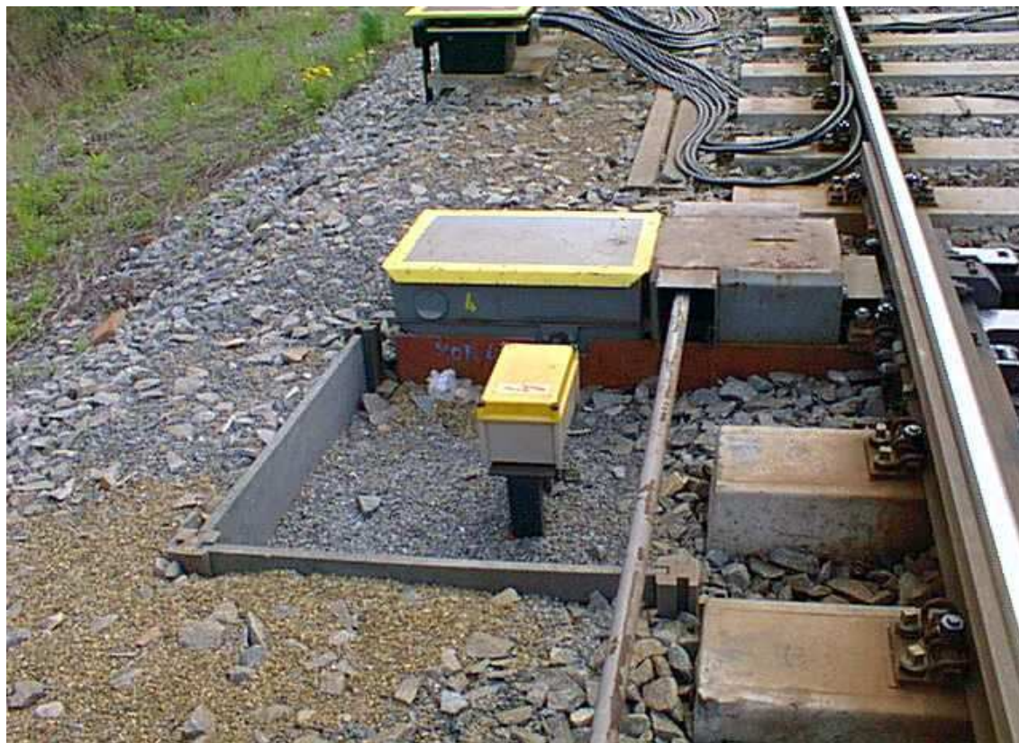
Žlabový prahec s vloženým elektrickým přestavníkem
