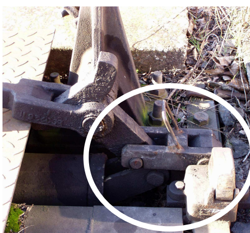
Samovratný přestavník (zapnutý do samovratné činnosti)
