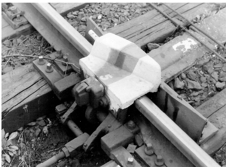
Výkolejka přestavovaná ručně s mechanickým zámkem
